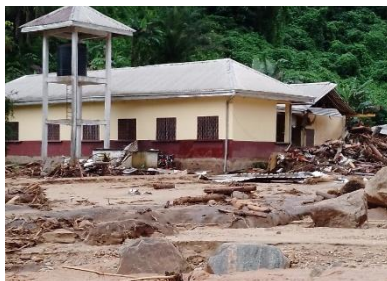
Photo 2 : Centre de santé de Bandoum détruit par les inondations
