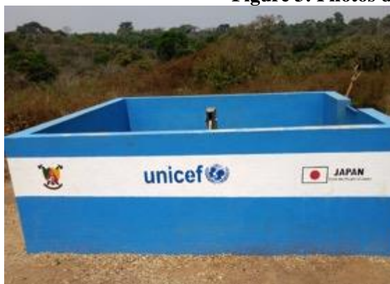
Forage neuf de Ngambadi dans la Région de l'Est (Photo OSD)
