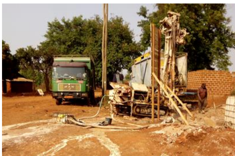
Forage en cours à moins de 20 mètres au Carrefour de routes départementales dans la Région de l'Est (Photo OSD)
